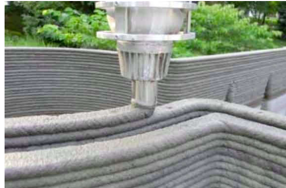
Thi công theo công nghệ in bê tông
